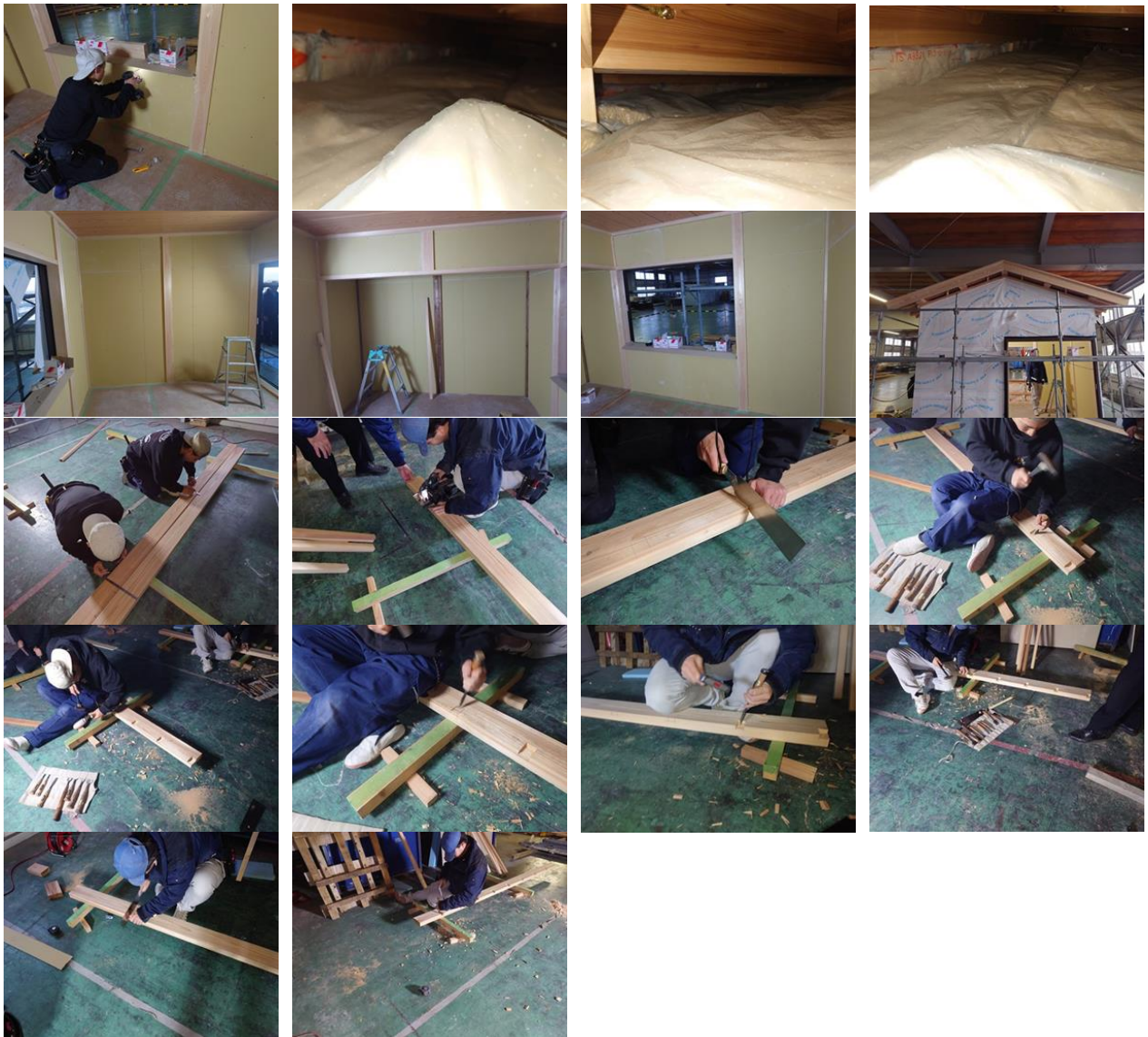
●2026/ 1/ 8（木）押入中段取付、雑巾摺り取付、付鴨居取付、寄取付（実習棟完成）、実習棟解体開始、完成ミーティング、廻り縁復習ほか
