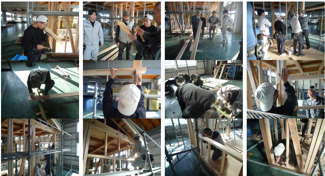
●11/20 (木) 鴨居の面取り、鴨居墨付け・刻み、鴨居取付、敷居刻み・取付、サッシ取付
