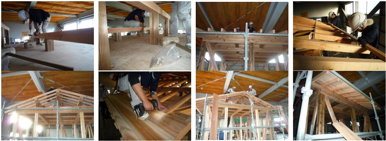
●11/13 (木) 茅負・淀取付、屋根化粧板取付、破風板取付、野地板下地、野地板張り、間柱取付
