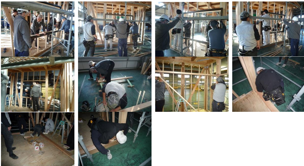
●11/27 (木) タイベック張り、防水テープ張り、壁断熱材入れ、壁下地、押入床張り
