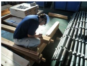
●10/30（木）柱刻み、床断熱材入れ、足場組立、床合板敷、建方、筋交い入れ、小屋裏合板敷、小屋束取付、母屋取付、屋根垂木取付
