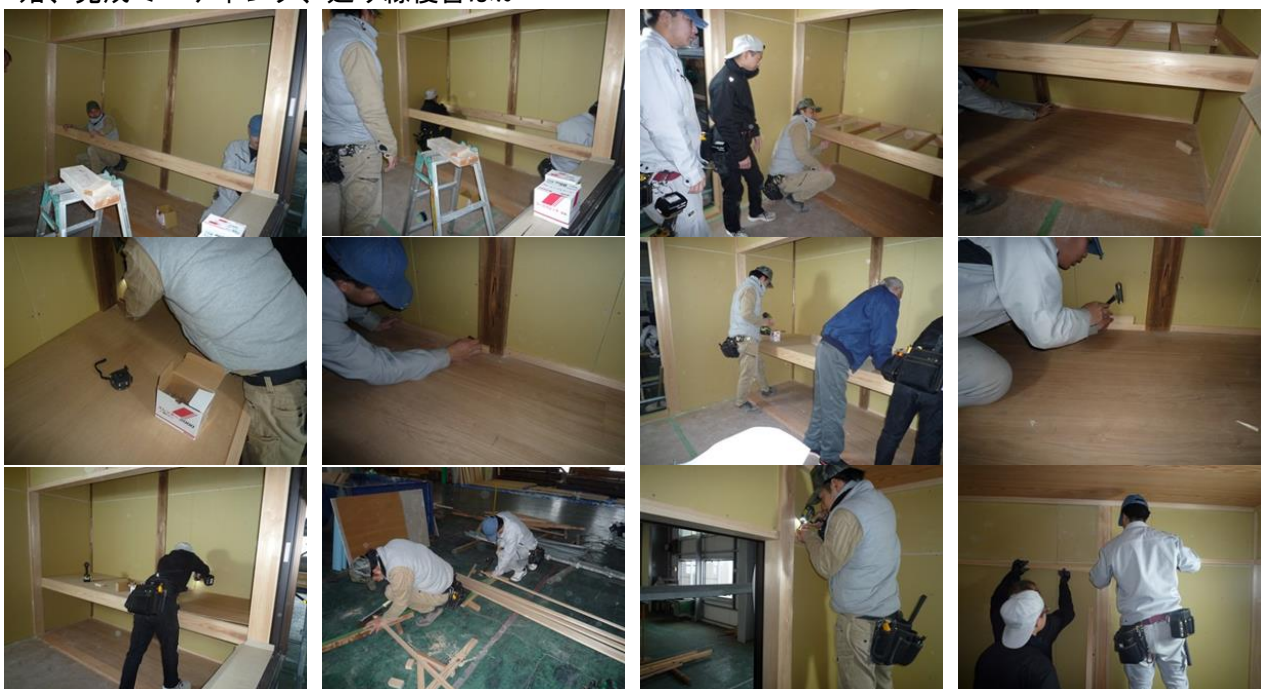
●2026/ 1/ 8（木）押入中段取付、雑巾摺り取付、付鴨居取付、寄取付（実習棟完成）、実習棟解体開始、完成ミーティング、廻り縁復習ほか
