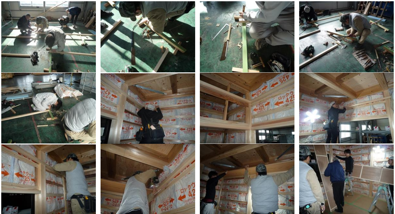
●12/11（木）和室廻り縁墨付・刻み、廻り縁取付、天井板割付、天井板張り開始
