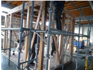
● 1/15 (木) 実習棟解体廃棄、足場解体・搬出、後片付け・清掃・点検、資機材・廃棄物搬出
