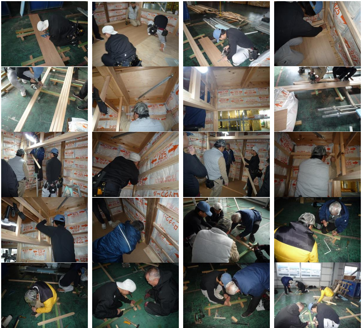
●12/11（木）和室廻り縁墨付・刻み、廻り縁取付、天井板割付、天井板張り開始
