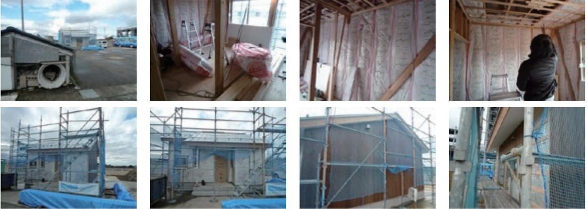
1/29 (水) グラスウール施工、天井下地、壁下地
