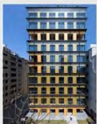
「Port Plus」 (大林組研修施設・横浜市)
