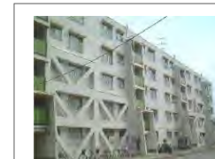
共同住宅 (外付けフレーム補強)
