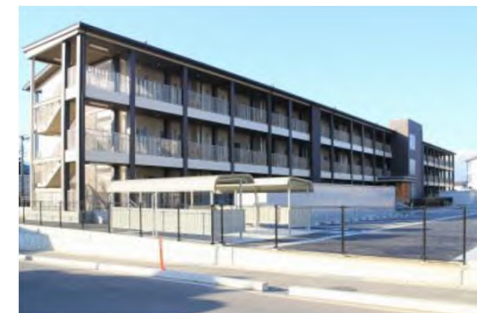
福島市北沢又団地 ・3階建て ・復興公営住宅
