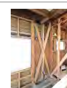
戸建住宅 (筋交いの設置等)
