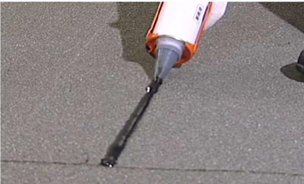
(1)シートの端部はGCラインで処理します。(320ccカートリッジ1本で8m程度が目安です)
