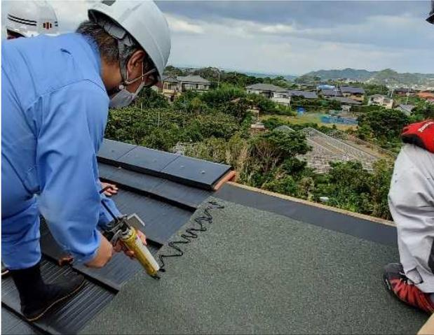
(1)重ねしろでない部分でシートを重ねる場合は、重ねる部分にGCラインをたっぷり塗布します。(幅10cm×1mで320ccカートリッジの1/3程度)
