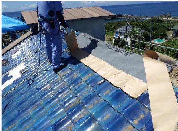
(1)エンシンシートの半分を瓦に、半分をスーパーブルーシートに貼ります。ある程度圧着させたあとに表紙を剥がします。
