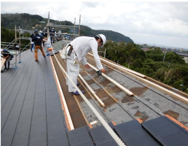
①棧木の取り付けは、木ネジで電動ドライバーを使います。
