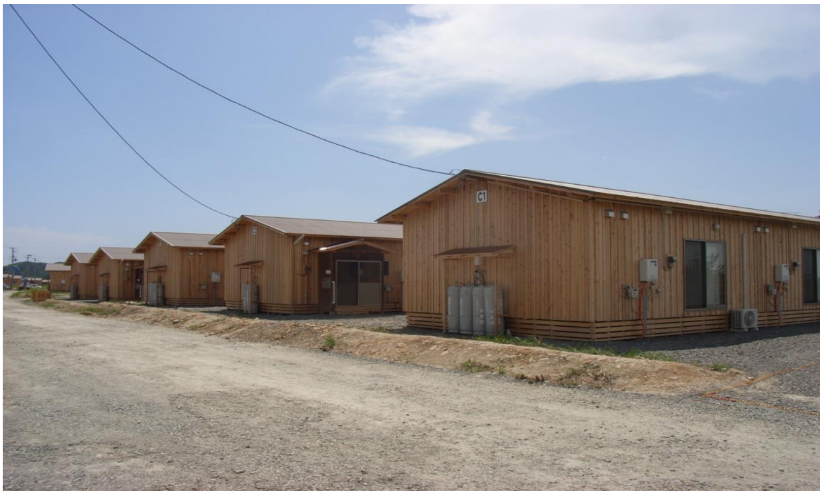
2011年 東日本大震災 (いわき市)
