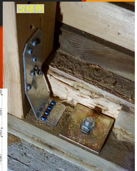
構造計算により適切な金物を使用
